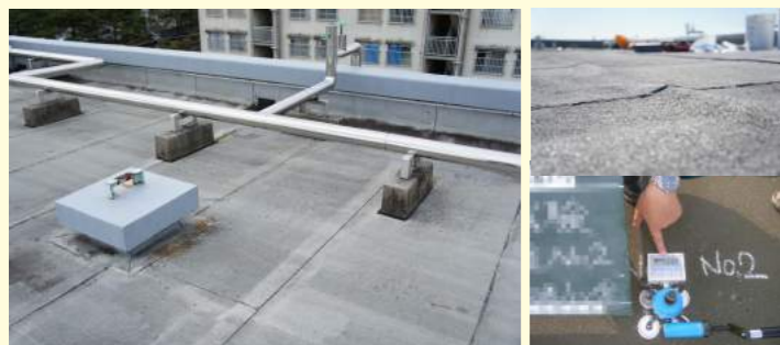
事前確認：アンカーピンの引張り試験
