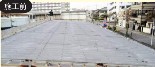
競輪場屋上（施工面積 850m 2 ） ※折板屋根
