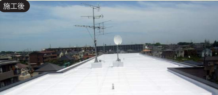
O マンション屋上（施工面積 2,100m 2 ） ※2004 年施工後⇒ 2017 年トップコート塗り替え改修工事
