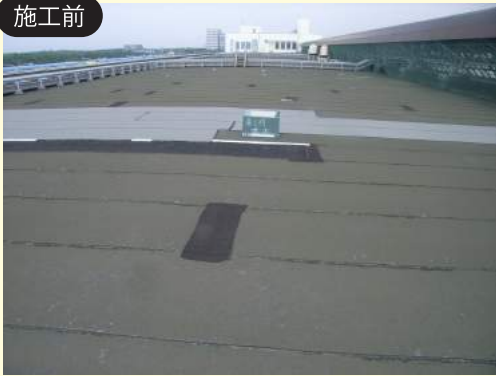
市場屋上（施工面積 3,018m 2 ） ※アスファルト露出防水 15 年経過後施工
